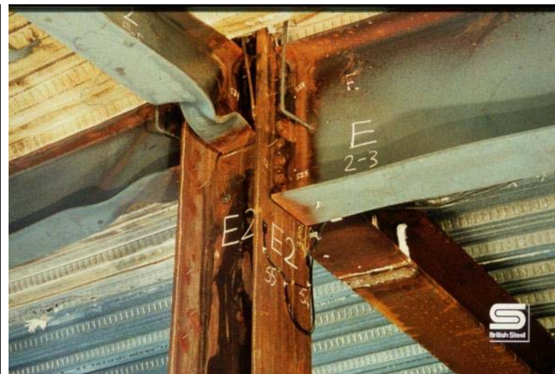
Nosníky u požárně chráněného sloupu
