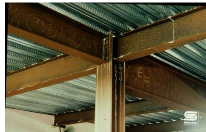
Přípoj nosníků na sloup
