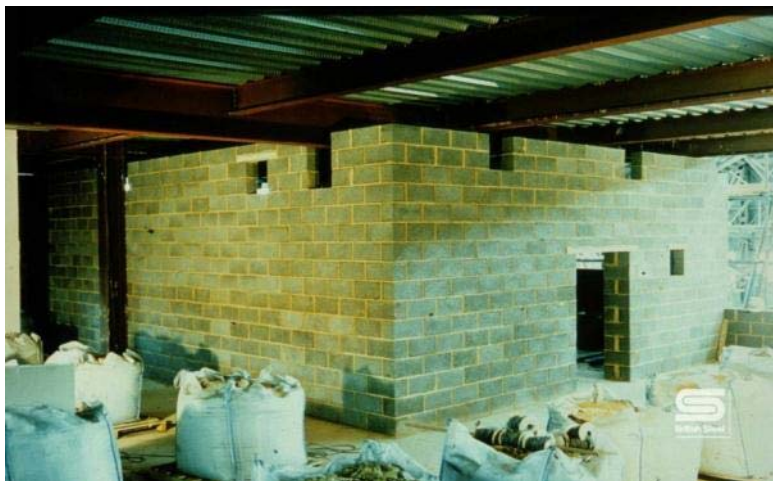
Stěny požárního úseku
