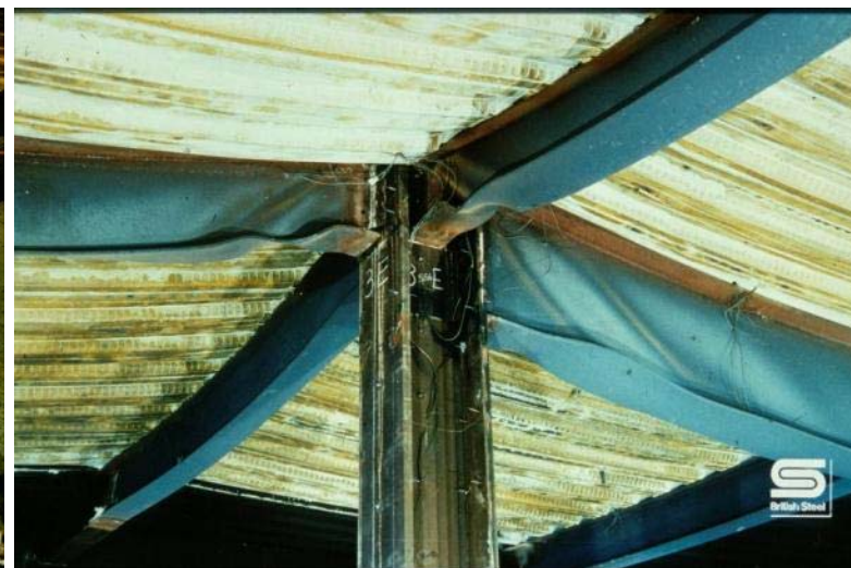
Přípoje nosníků na sloup
