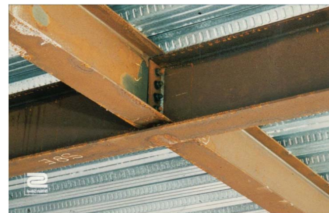
Přípoj stropnice na průvlak
