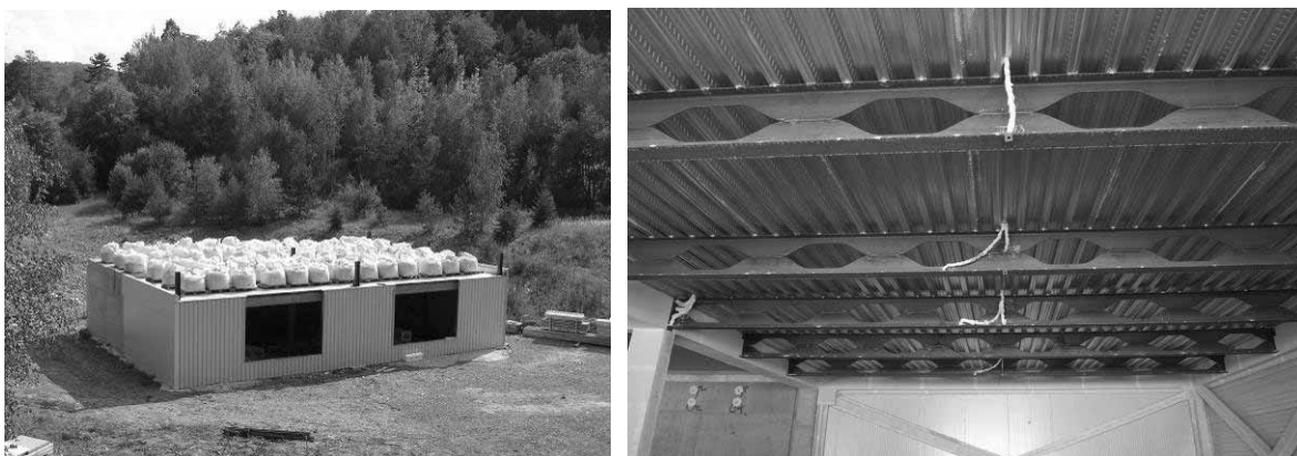
Obr. 53 Mechanické zatížení pytlí se šěrskem a měření teploty stropu termočlánky
