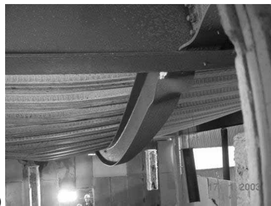
Obr. 42a) Požární úsek po požáru, b) zbytková deformace ocelobetonové desky 925 mm
