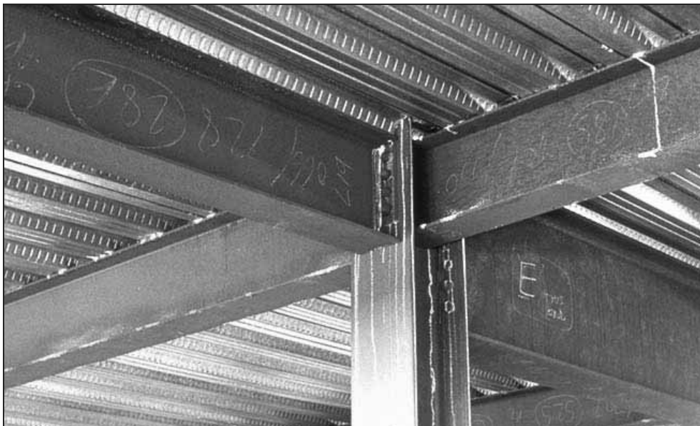
Obr. 1 Zkušební budova v Cardingtonu před betonáží desek
