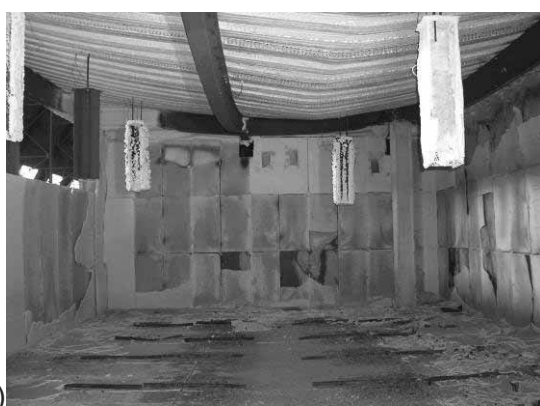
Obr. 42a) Požární úsek po požáru, b) zbytková deformace ocelobetonové desky 925 mm
