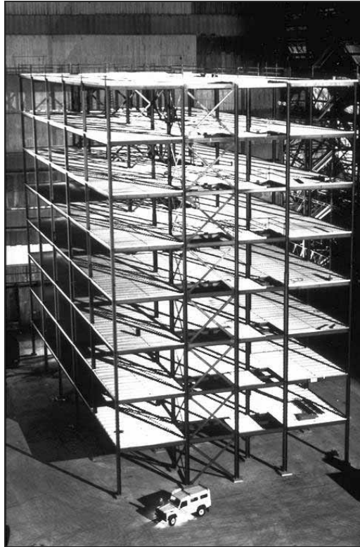
Obr. 1 Zkušební budova v Cardingtonu před betonáží desek
