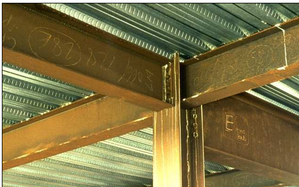
Rys. 1.2 Widok niezabezpieczonej konstrukcji stalowej
