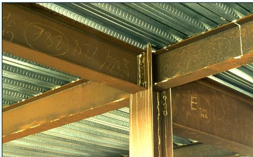
Sl. 1.2 Nezaščitena jeklena konstrukcija
