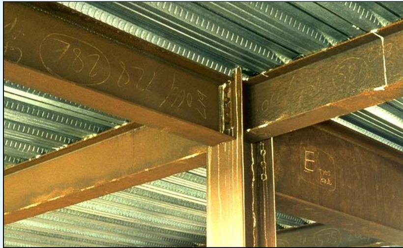
Figura 1.2 Estructura de acero sin proteger
