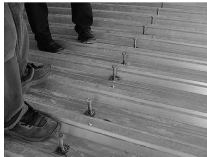
Trny přivařené skrz trapézový plech
