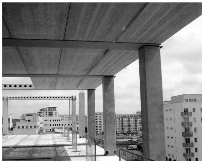
Stropní konstrukce slim floor
