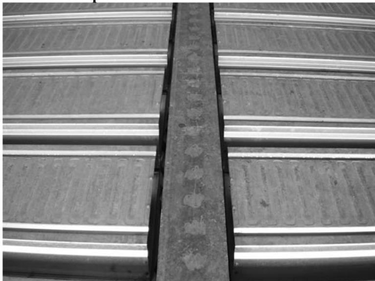
Stropní konstrukce slim floor
