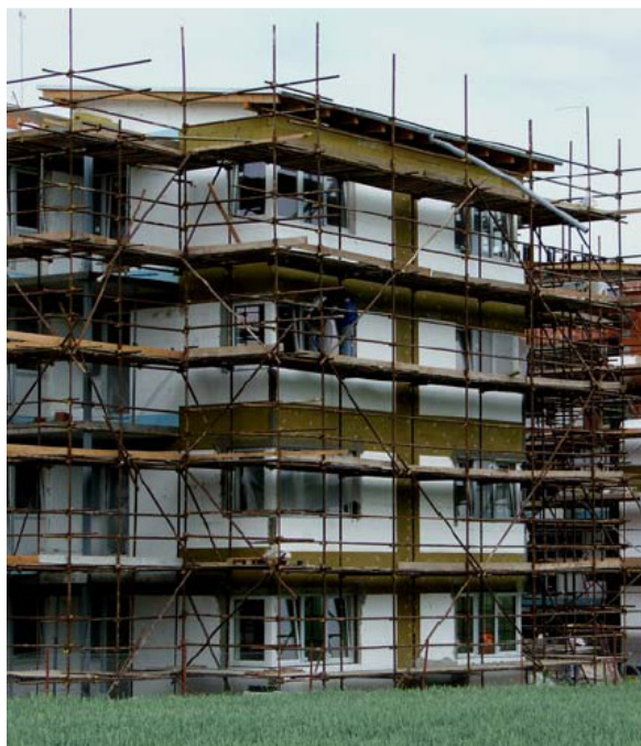
Obr. 2.5 Novostavba bytového domu v Praze Letňanech s požárními pásy zateplenými z MV, zbylá část EPS-f
