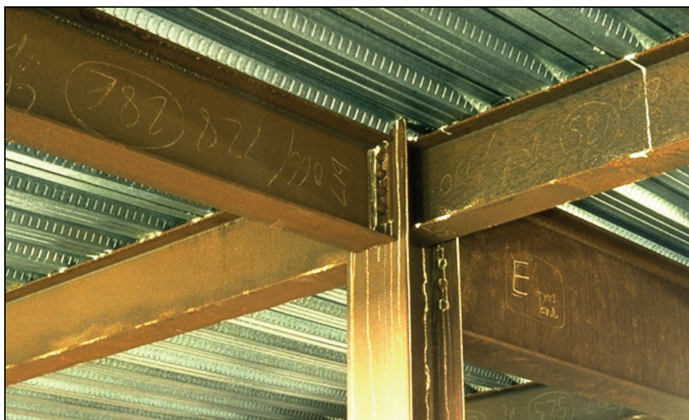
Obr. 5.1 Zkušební budova v Cardingtonu před betonáží desek
