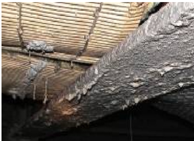
Obr.2.10 Nesprávně namíchaný a provedený nástřik
