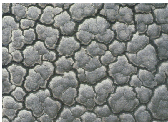
Obr.2.1 Povrch po odpaření hořlavých plynů z dřevotřískové desky při požáru
