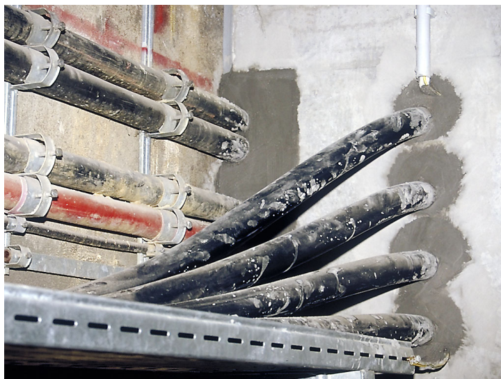
Obr. 3.6 Kabelová přepážka z protipožární malty
